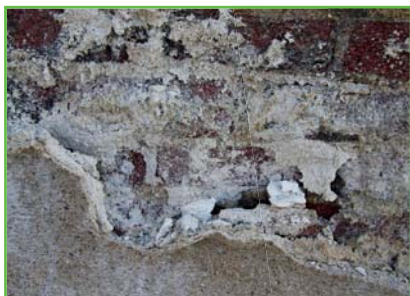
Typowe zniszczenia spowodowane przez wykwit solny.
