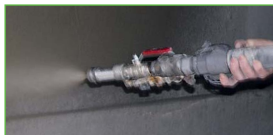
Mikrozaprawa uszczelniająca KÖSTER NB I, 2. warstwa
